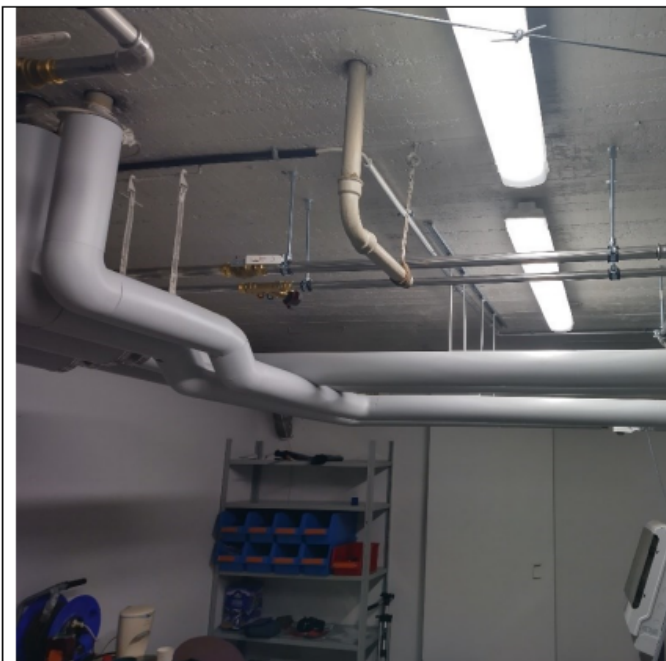
Lämmönjakohuoneen runkoputket
