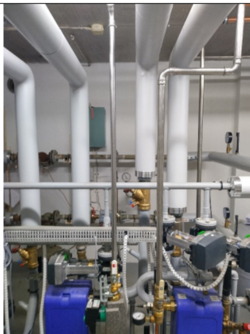
Lämmönjakohuoneen runkoputket
